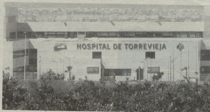
Private-Public-Partnership: Krankenhaus Torrevieja. Foto: M. Allhoff
